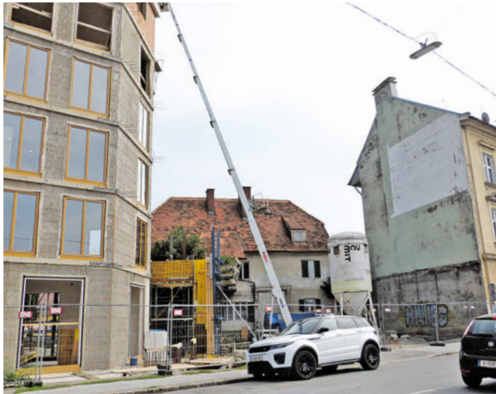
Wo einst in der Wiener Straße eine Hufschmiede stand, befindet sich heute ein sechsgeschossiger Neubau.
